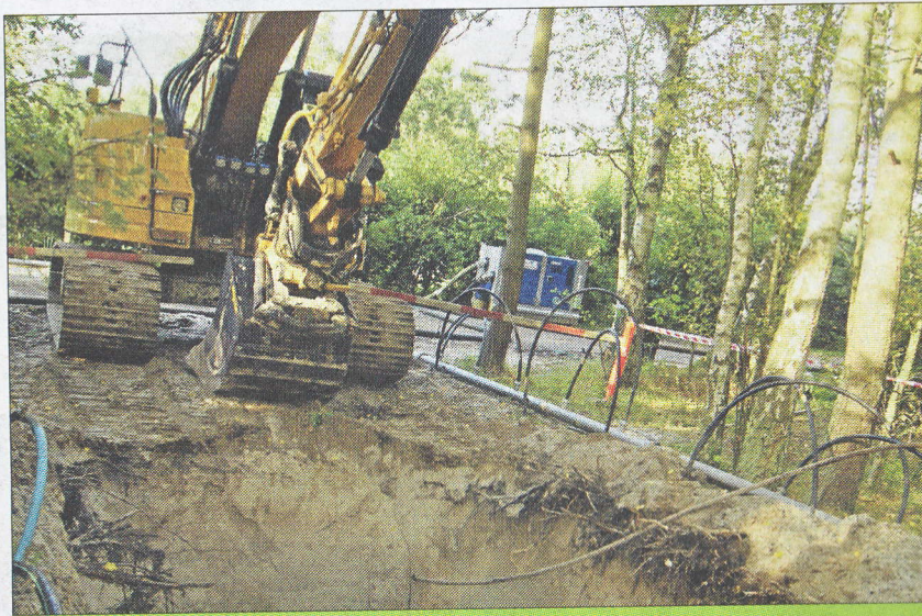
Gravearbejdet i sommerhusområderne er ofte besværet af, at pladsen er trang.
